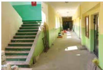
Remont szkoły w Radomyśli. Fot. UG
