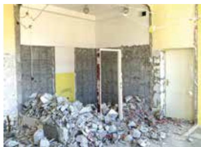
Remont szkoły w Śmiarach. Fot. UG
