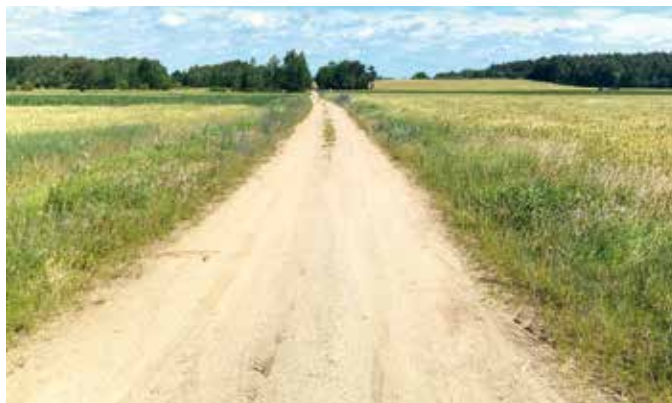
Droga w Okninach. Fot. UG
