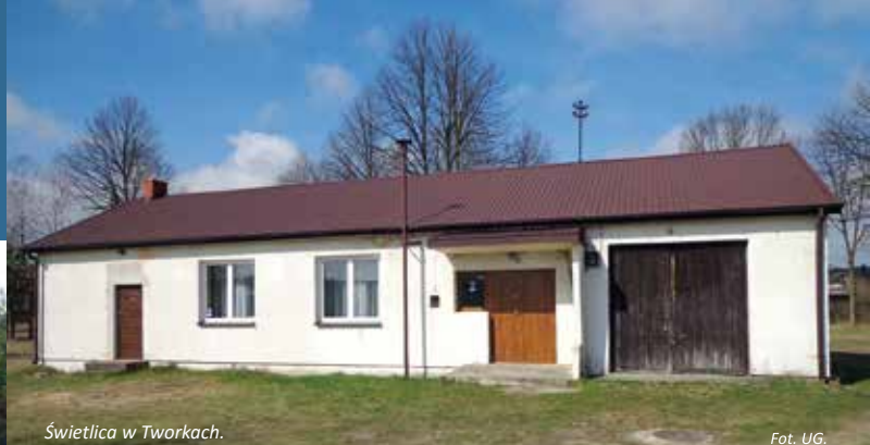
Świetlica w Tworkach.
