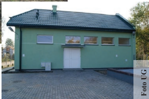
SUW przed i po remoncie (od frontu).
