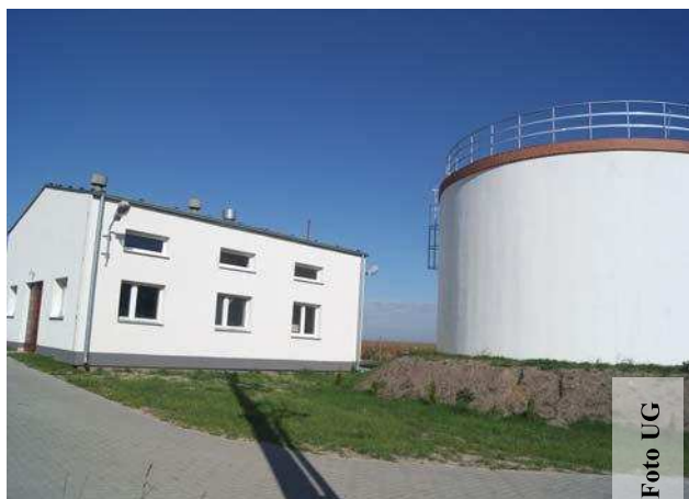
Stacja uzdatniania wody w Radomyśli po remoncie.
