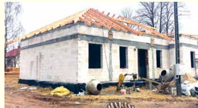
Świetlica budowana w Daćbogach. Fot. UG
