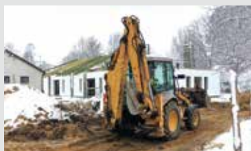
Remont świetlicy w Tworkach. Fot. UG
