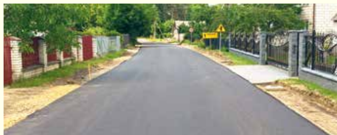
Droga w Lipniaku. Fot. UG
