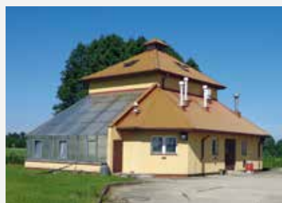
Oczyszczalnia ścieków w Wiśniewie. Fot. UG
