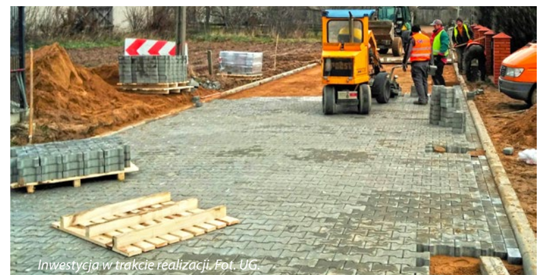
Inwestycja w trakcie realizacji. Fot. UG.
