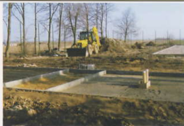
Prace przy kompleksie boisk na terenie szkoły w Wiśniewie. Fot. UG
