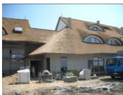
Hotel REMES w budowie
