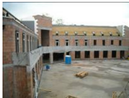
Hotel w trakcie budowy
