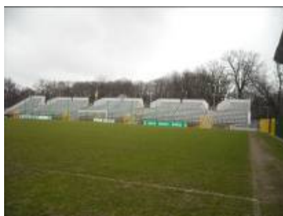
Stadion miejski podczas przebudowy
