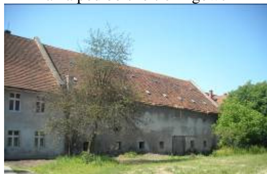
Budynek hotelowy w modernizacji
