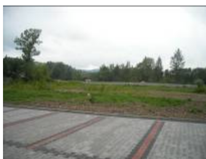
Boiska boczne – budowa
