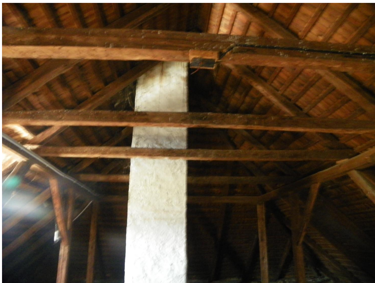
Foto 1. Widok konstrukcji więźby na poddaszu
