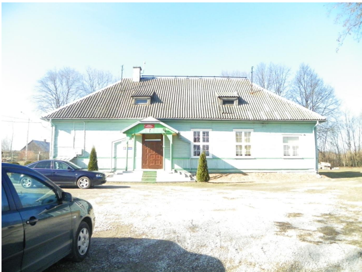
Foto. 4. Elewacja południowo- wschodnia
