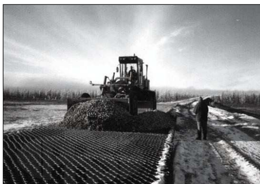
Rys. 6. Zasypywanie kruszywem komórek geosiatki za pomocą równiarki
