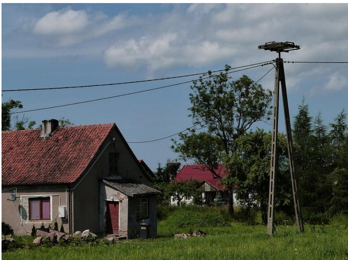
Fot. 2. Pusta platforma – HF na słupie energetycznym podłączonym do sieci betonowym typu A – SEBA.
