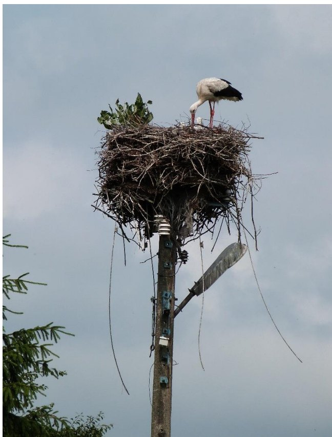
Fot. 14. Słup wolnostojący betonowy pojedynczy typu I – SWBI.
