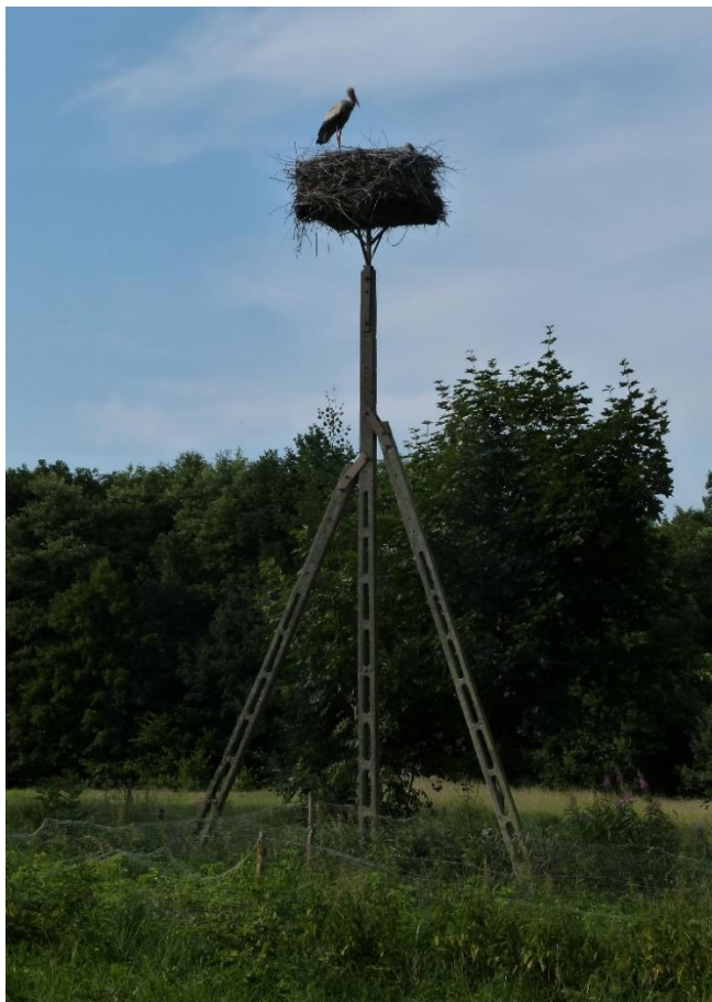
Fot. 13. Słup wolnostojący betonowy pojedynczy typu I – SWBI, wzmocniony z obu stron podporami.
