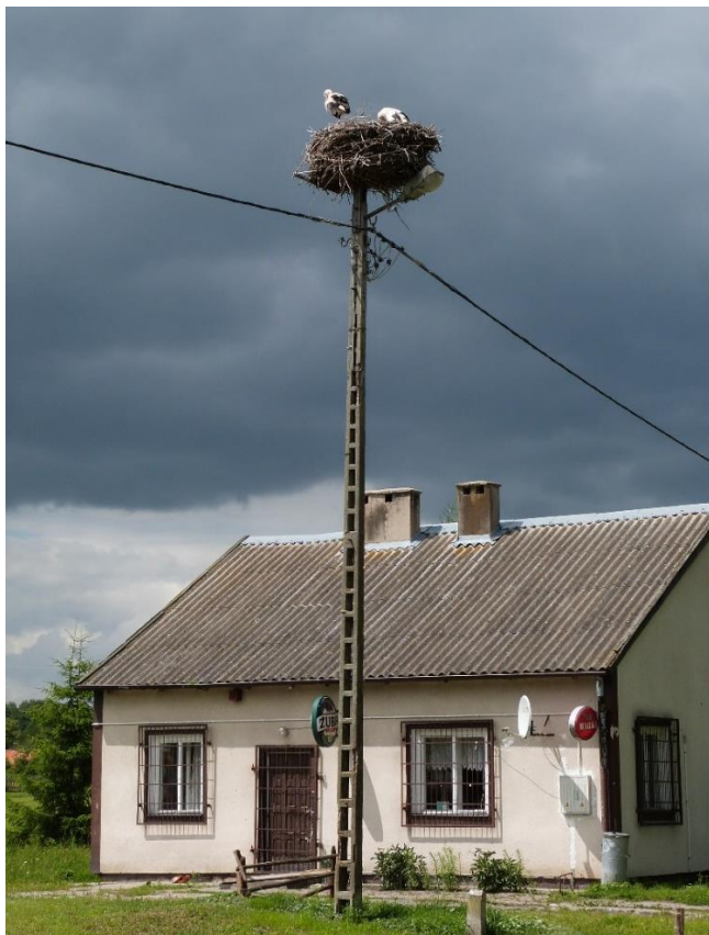
Fot. 9. Gniazdo na słupie energetycznym podłączonym do sieci betonowym pojedynczym typu I – SEBI.
