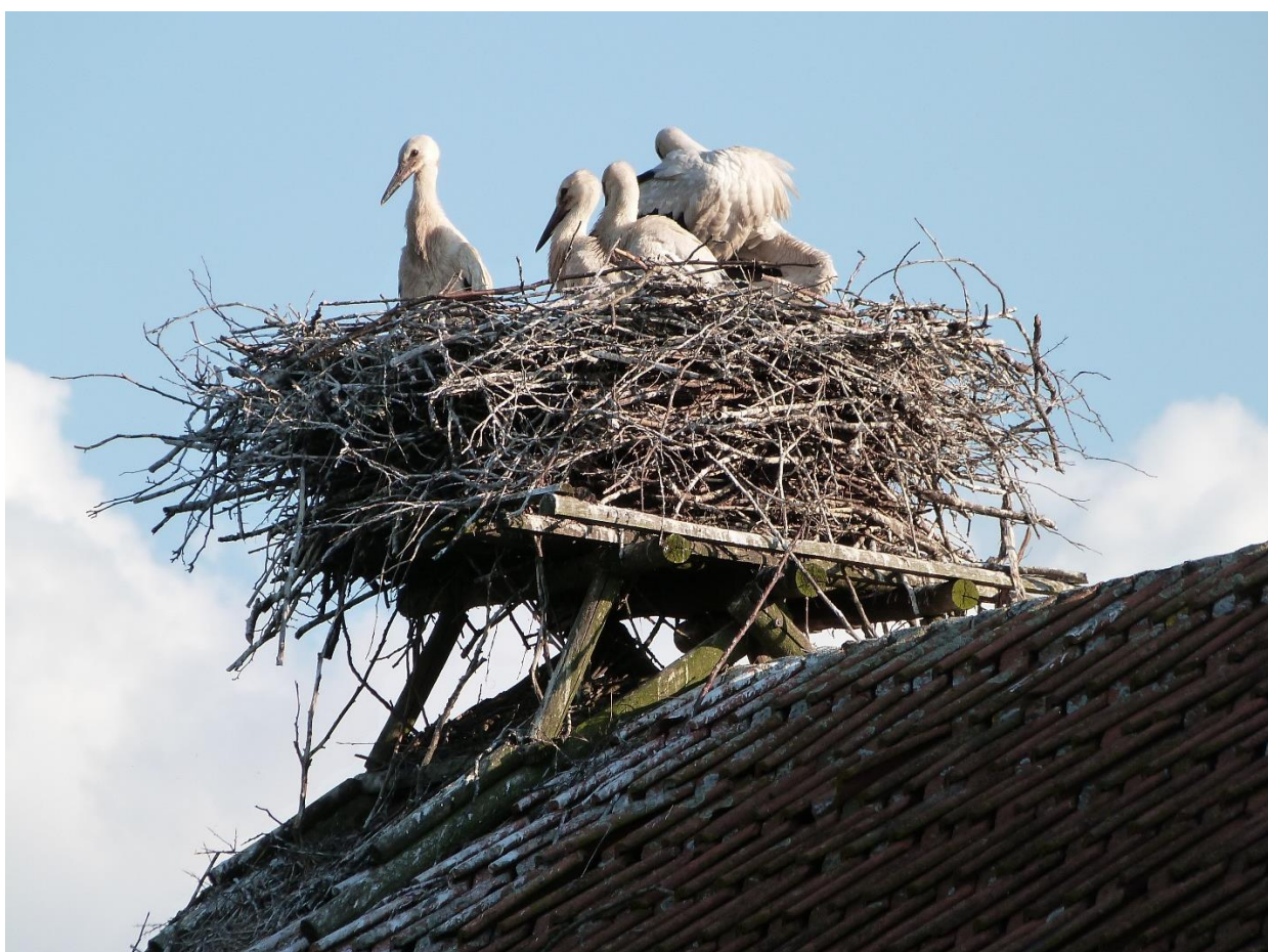
Fot. 30. Gniazdo osadzone na platformie drewnianej – PD, założonej na dachu budynku.
