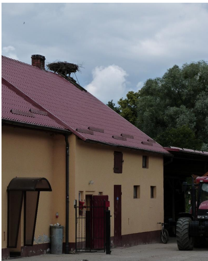
Fot. 24. Bocianie gniazdo na budynku gospodarczym o nieokreślonym przeznaczeniu, pokrytym blachodachówką – BGB.
