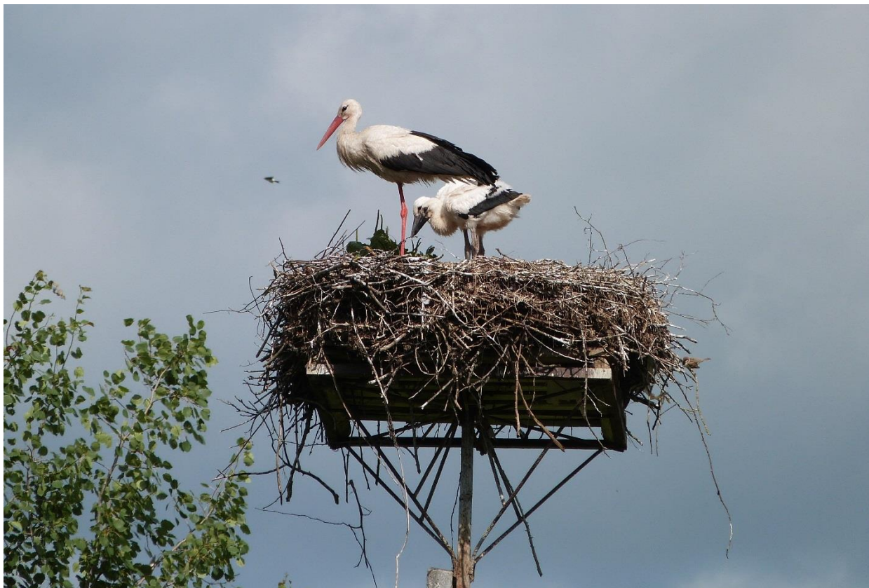
Fot. 29. Gniazdo osadzone na platformie metalowej – PM, zamontowanej na słupie.
