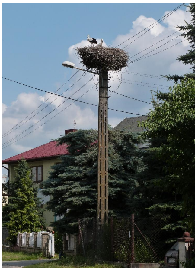
Fot. 10. Gniazdo na słupie energetycznym podłączonym do sieci betonowym podwójnym typu II – SEBII.
